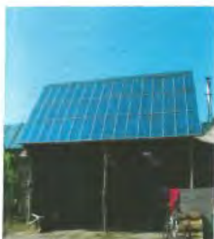
sur une remise
